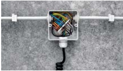
Bild 8: Halter zur Aufnahme von verschiedenen Serien schraubenlosen Wago-Installationsklemmen
