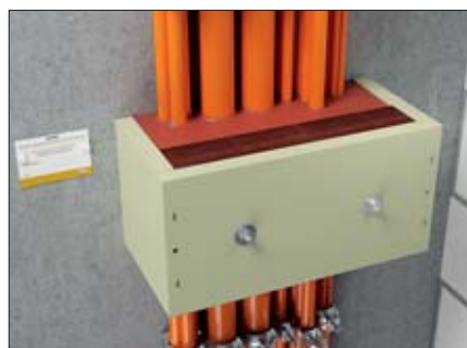
Bild 4: Die Schaumstofffüllung unterstützt bei hoher Kabelbelegung die zugentlastung
