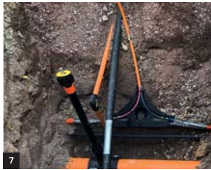
Bild 6: Doppelsteckmuffen – der Sicherungsring verhindert ein ungewolltes Lösen der Verbinder
