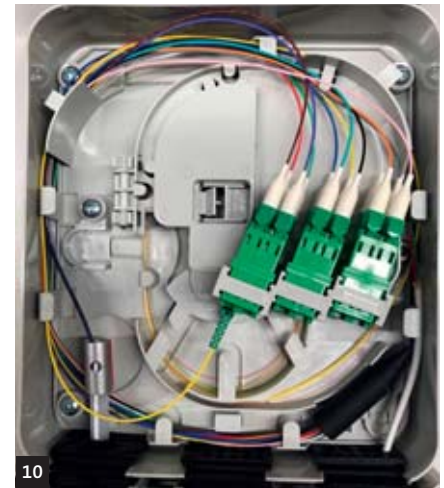
Bild 10: EZA auf MR 7/4mm in einem Gf-AP
