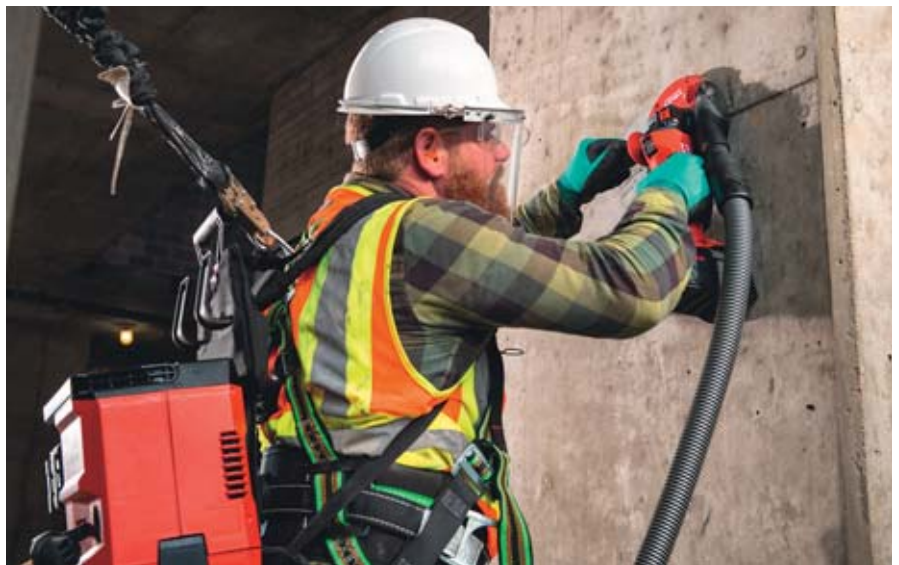
Bild 1: Der Akku-Winkelschleifer »AG 6D-22« erzielt die doppelte Schnittgeschwindigkeit im Vergleich mit dem Vorgängermodell
