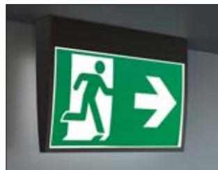
Leuchten besteht aus Einzelbatterieleuchten mit 868-MHz-Funktechnik, die drahtlos gesteuert und überwacht werden. Zur Installation ist lediglich die herkömmliche Spannungsversorgung mit 230 V AC notwendig.
