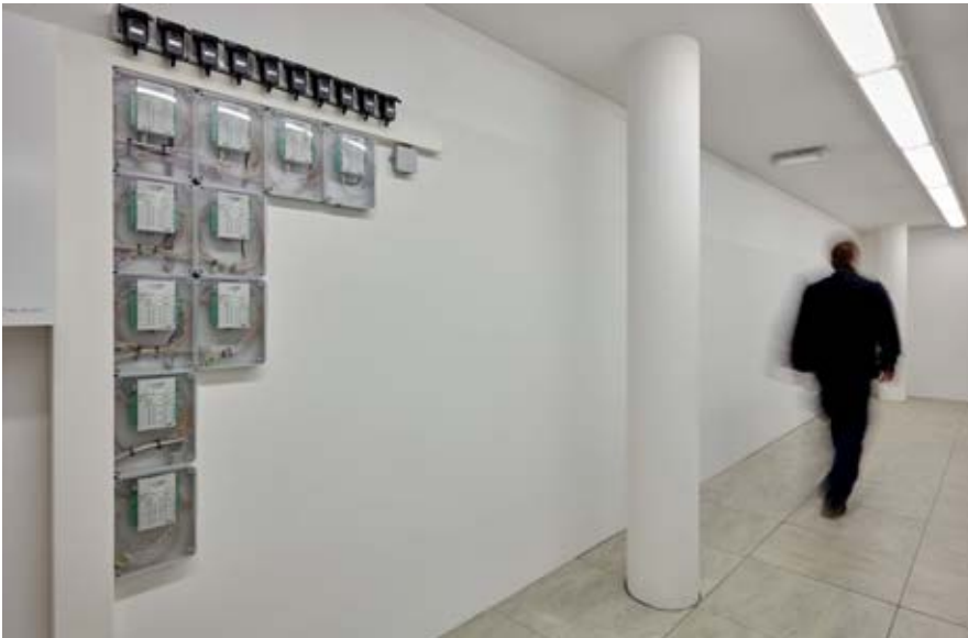
Bild 4: Dank der Türsteuerungen lassen sich bis zu zehn Türen über eine IP-Adresse anbinden
