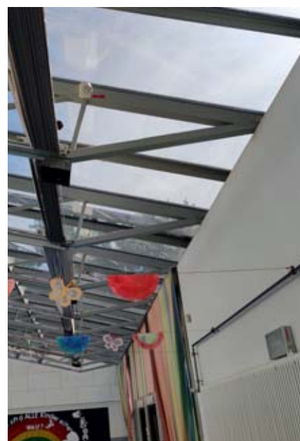
Bild 4: Die Mehrsensormelder sind auch für den Einsatz unter schwierigen Bedingungen geeignet – beispielsweise arbeiten sie bei Temperaturen zwischen -10^{\circ}\text{C} und +50^{\circ}\text{C}
