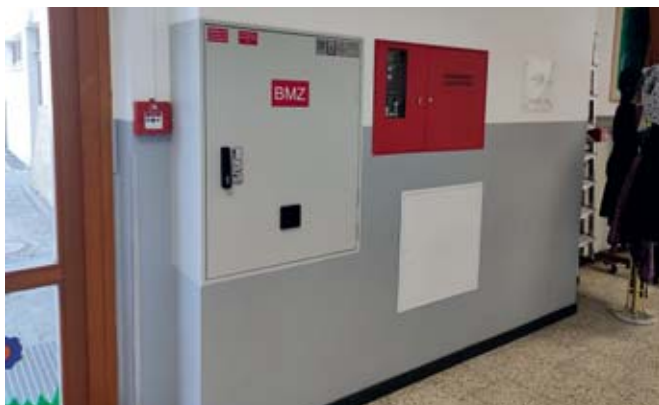
Bild 2: Die »hifire 4400« Brandmelderzentrale von Telenot ist in einem feuerfesten Gehäuse untergebracht
