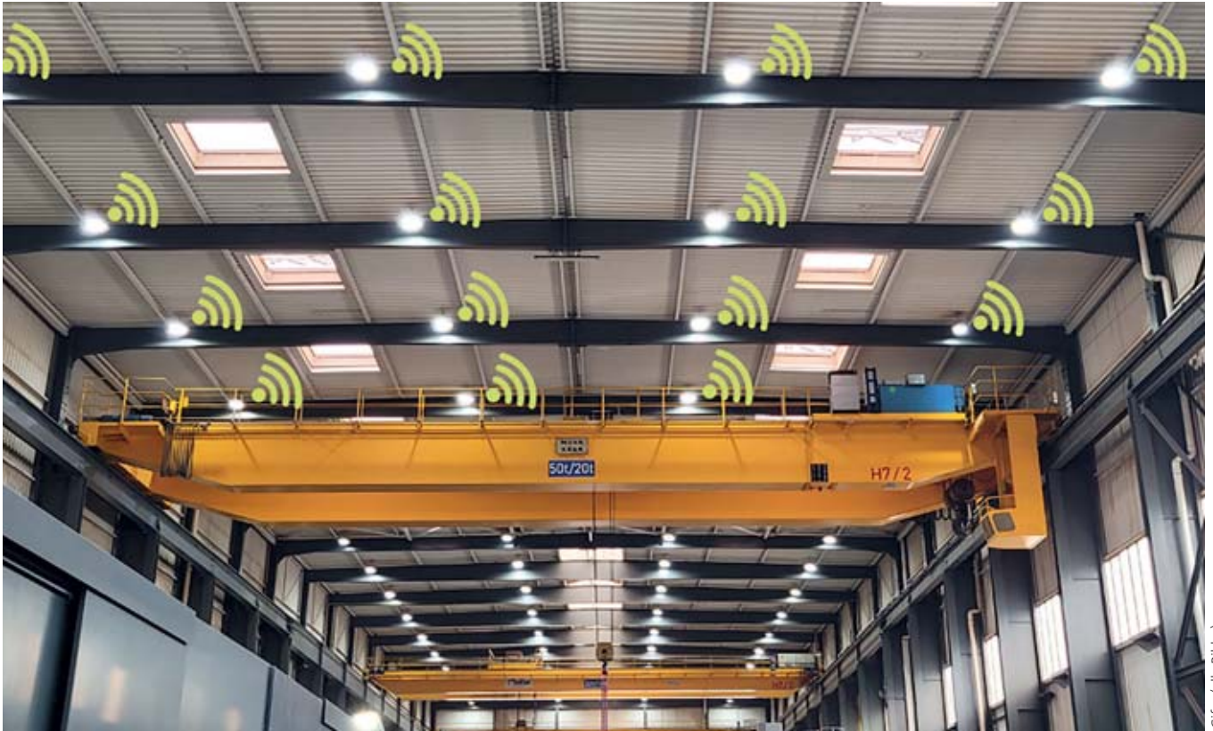
Bild 1: Die Steuerung der LED-Hallenstrahler in Produktionsstätten und Industriegebäuden kann über Zigbee drahtlos erfolgen
