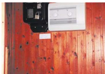
*Bild 4: Münzzähler in einer Schwimmhalle vor der Saunatur ohne Feuchtigkeitsschutz*
