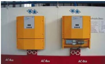
**Bild 1:** Die Batteriestromrichter »Sunny Island« von SMA verfügen über ein Batteriemangementsystem mit Ladezustandserfassung und Batteriezustandsbestimmung
