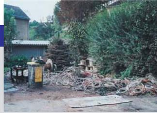
**Bild 1: Etliche Meter Installationskabel mussten entsorgt werden, eine Wiederverwendung war ausgeschlossen**
