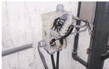
**Bild 6:** Netzspannung und Schutzkleinspannung in einem gemeinsamen Verbindungskasten ohne ausreichenden Spritzwasserschutz
