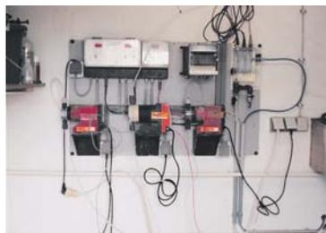
**Bild 5:** Fehler in Mess-, Regel- und Dosieranlage für Schwimmbad-Chemikalien – Zuleitung über Verlängerungsleitung angeschlossen, Steckdosen für Dosierpumpen nicht gekennzeichnet, Dosierschläuche nicht gekennzeichnet, keine Verriegelung der Dosierpumpen über einen Strömungswächter
