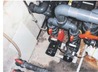
*Bild 1: Fehler – Filterpumpen sind nicht einzeln schaltbar; wenn eine Pumpe, z. B. wegen eines Defekts, abgeschaltet werden muss, fällt die gesamte Filteranlage aus*
