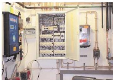
*Bild 3: Fehler – Sicherungsverteilung für Schwimmhalle und Schwimmbadtechnik ohne Fehlerstrom-Schutzeinrichtung*
