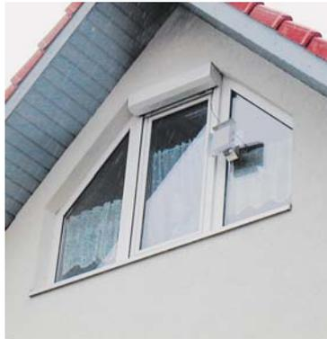
**Bild 1:** Kundenanschluss für das Funknetz von Airdata AG, Außenmontage
