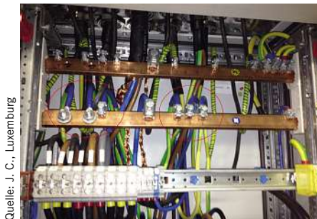
Bild 1: Hier wurden grün-gelbe Adern blau gekennzeichnet
