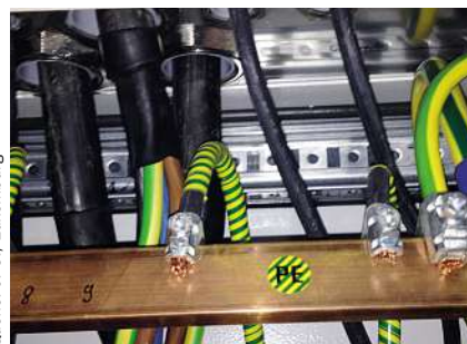
Bild 2: Hier wurden schwarze Adern grün-gelb gekennzeichnet
