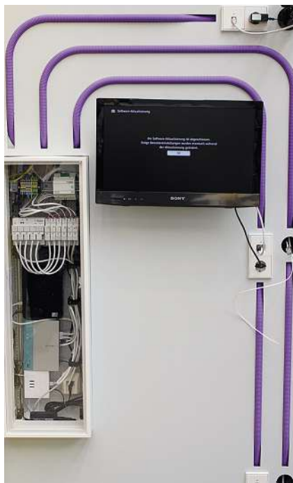
Bild 2: Integration in der Unterverteilung – kombiniert mit dem TCP/IP-Netz
