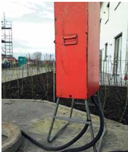
Bild 2: »Vorgeschalteter« Baustromverteiler – von dort geht es zum Beitragsobjekt (Hintergrund)
