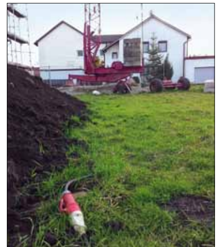
Bild 4: Mal »zackig« in Richtung Baukran verlängert – ungeschützte Verlegung der Leitungen
