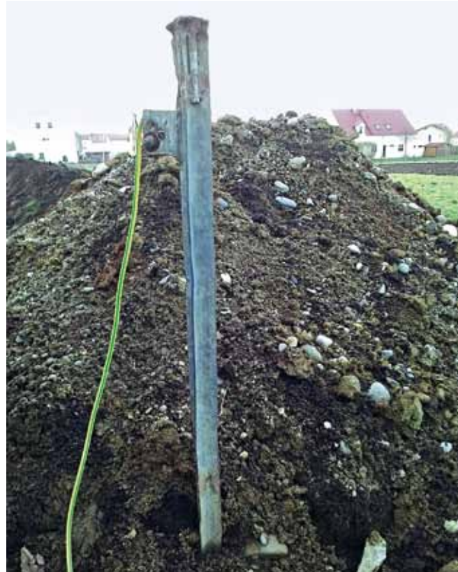
Bild 5: Erder ohne Tiefgang – so besser nicht
