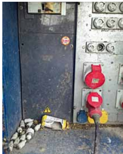
Bild 3: Bei Nähe betrachtet – diese RCD war definitiv zu lange in der Sonne
