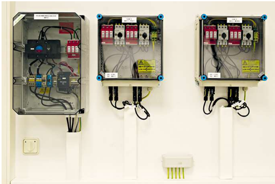
Bild 2: Trenneinrichtungen in PV-Anlagen
