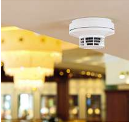
Bild 2: Restaurants und Bars werden am besten mit Mehrfachsensormeldern überwacht
