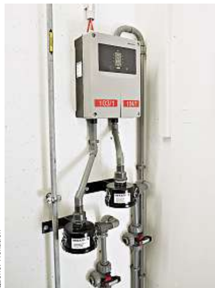
Bild 4: Zur Überwachung von Aufzugsschächten eignen sich Ansaugrauchmelder
