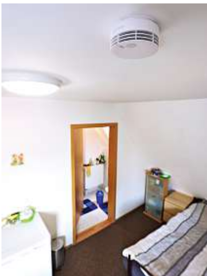
Bild 3: Rauchwarnmelder mit Zehn-Jahres-Batterien sind eine Option für Wohnungen in Hochhäusern
