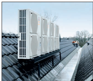
Verdampfer/ Kompressor-Einheiten der gesplitteten Luft/ Wasser-Wärmepumpen-Kaskade auf dem Dach des Gebäudekomplexes
