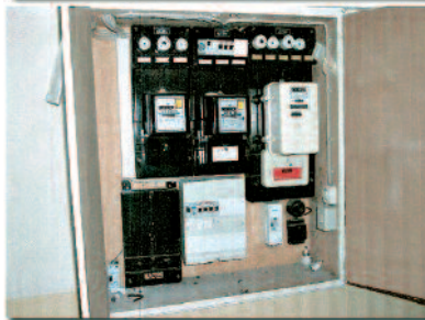
Fotos des Anfragers: Installation auf Holz
