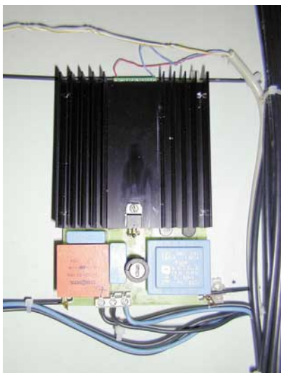
Bild 1: Trafo in »Spannschleife-Montage«
