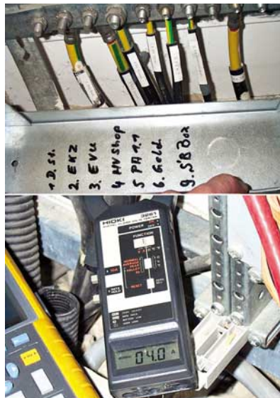
Bild 4: Potentialausgleichsschiene PAS - Fehlerstrom von 4 A effektiv
