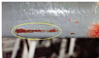
Bild 5: Rohr einer Sprinkleranlage mit einem 10 cm langen Schlitz
