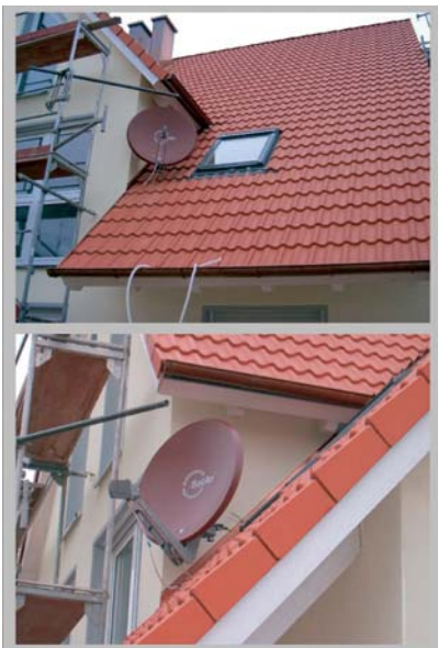
Bild 2: Vorgefundene Montagesituation einer Satellitenempfangsanlage
