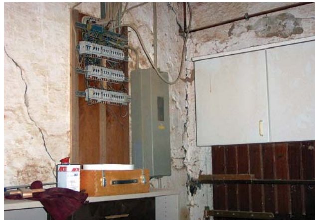
Bild 20: Abenteuerliche Elektroinstallation in einer Tischlerei
