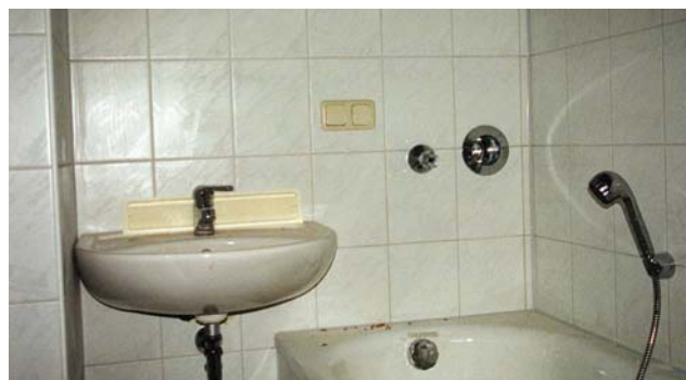
Bild 21: Doppelsteckdose im Schutzbereich der Badewanne
