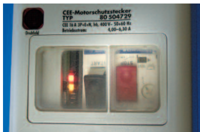
Bild 4: Alles schläft, einer wacht: Das Fehlerschutzsystem mit integrierter Telematikfunktion wird auch bei Netzspannungsausfall aktiv
