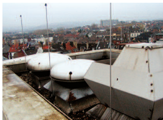
Bild 2: Die Fangspitzen neben den Ventilatoren sind nicht nur zu lang (über 50 cm), sondern sind auch direkt mit den geschützten Aufbauten verbunden, was nicht erlaubt ist. Bei einer solchen Ausführung werden Teilblitze ins Gebäudeinnere geleitet, wo dann durch Überschläge und Kopplungen andere Einrichtungen zerstört werden können – ein Bestandsschutz entfällt auch hier.
