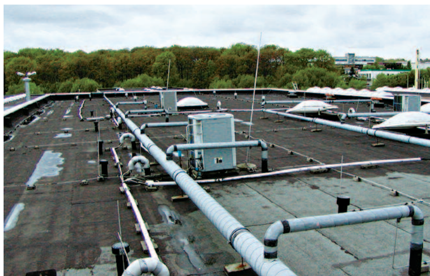
Bild 1: Die Fangeinrichtung am Dachrand liegt unterhalb der Blechaußenkanten. In der Mitte sind auch andere Einrichtungen und Elektrokabel höher als die Fangeinrichtung oder berühren diese – ein Bestandsschutz entfällt daher.
