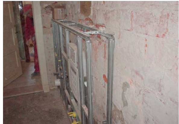
Ein Vorwandmontagesystem braucht nicht in den zusätzlichen Potentialausgleich einbezogen werden
