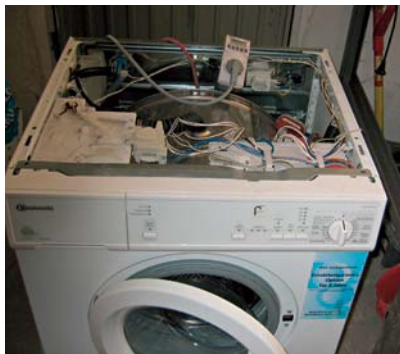
Bild 1: Messungen in einer Kundenwerkstatt an einer mit der in der Anfrage vergleichbaren Waschmaschine
