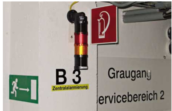
Bild 3: Signalsäule mit AS-i-Anschluss; die Verwendung von AS-i spart die separate Energieversorgungsleitung
