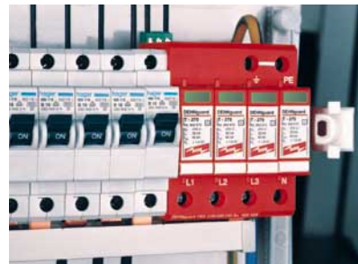
Bild 54: TN-S-System, vier Ableiter (Varistoren) gegen PE geschaltet
