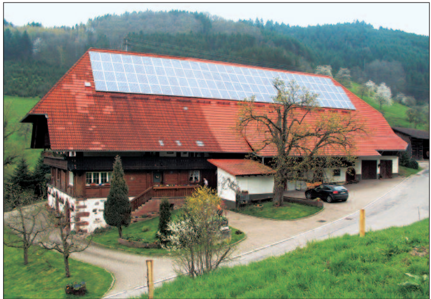
Bild 2: Die größte von der Schwarz GmbH ausgeführten Photovoltaikanlagen hat 20kW Spitzenleistung
