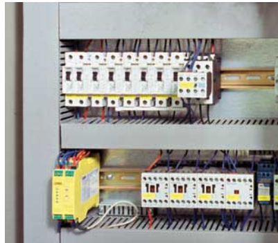
Bild 2: Sicherheitsrelais überwachen die Notaus- sowie die Schutztürstromkreise
