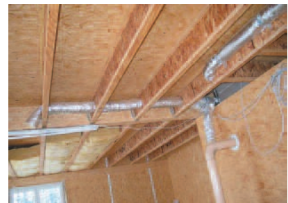
Bild 2: Deckenverteilung der Wohnungslüftung
