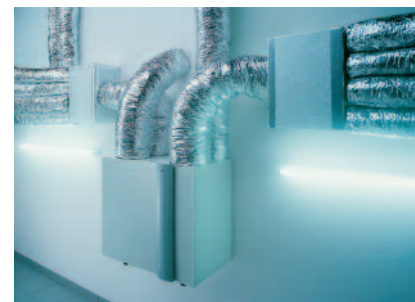
Bild 3: Wohnungslüftungsgerät an zentraler Stelle installiert
