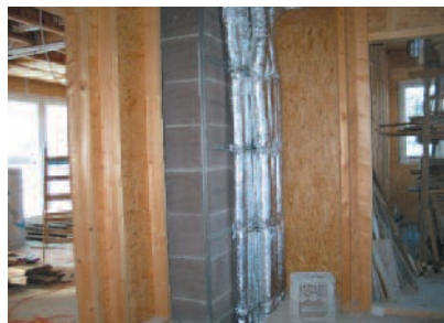
Bild 1: Senkrechte Verlegung der Lüftungsleitung
