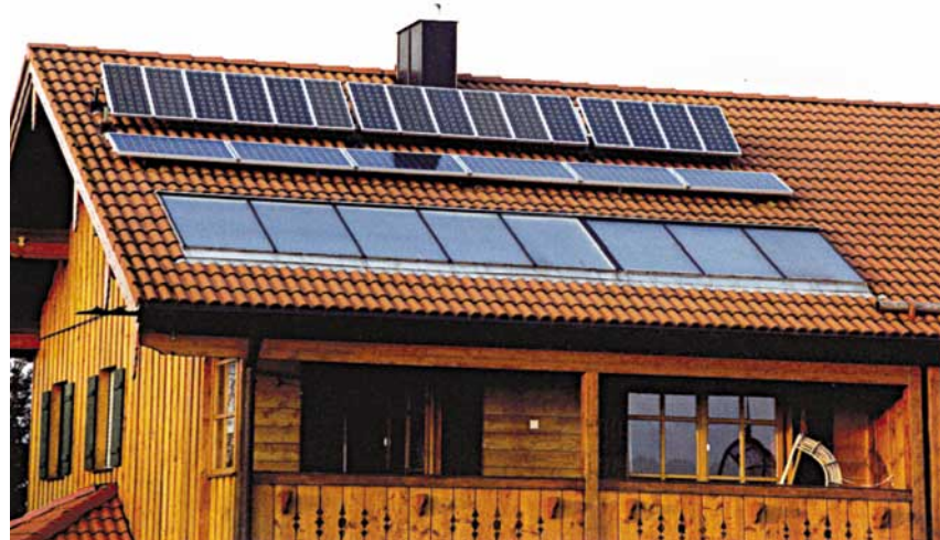
Bild 1: Einfamilienhaus mit Aufdach-Photovoltaikanlage; gerade in diesem Bereich lassen sich Anlagen zwischen 1 kWp und 7,5 kWp installieren
