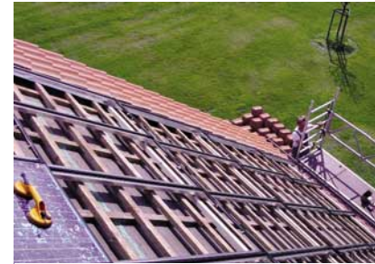
Bild 2: Tragekonstruktion Sol-25i; die Montage beginnt von unten, die einzelnen Träger überlappen sich, um später die Dichtigkeit der Module zu gewährleisten
