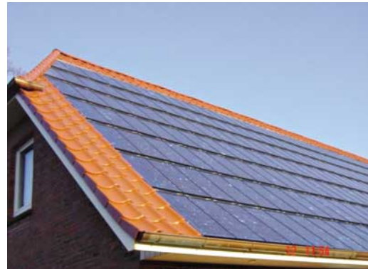
Bild 1: Walmdach mit Indach-Solarstromanlage; die rahmenlosen Module ersetzen die Dachpfannen oder -ziegel
