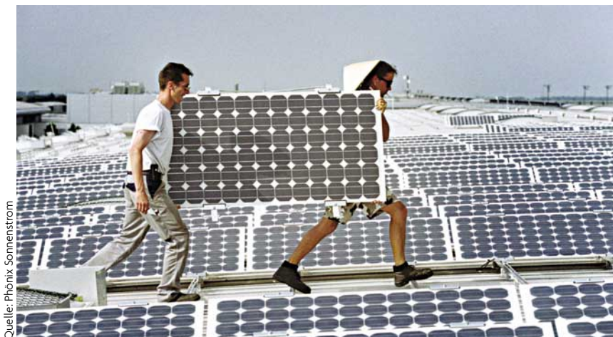
Bild 2: Installation einer Aufdachanlage auf den südlichen Messehallen München durch eigene Monteure der Phönix Sonnenstrom AG
