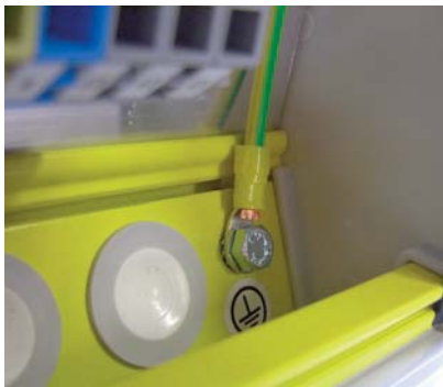
Bild 2: Möglichkeit eines normgerechten Schutzleiteranschlusses
