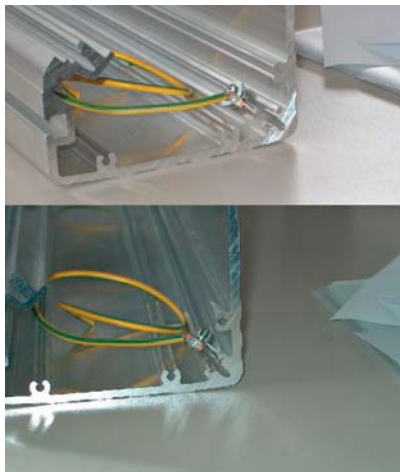
Bild 1: Nicht normgerechter Schutzleiteranschluss
