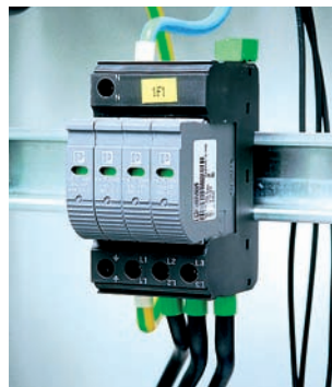
Bild 4: Die Überspannungsableiter sorgen für eine Spannungsbegrenzung auf 1,5 kV
