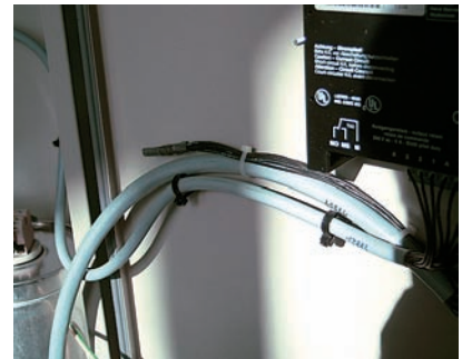
Bild 3: Aderenden mit Schrumpfschlauch isoliert; hier zur Demonstration lose neben ein bestehendes Steuerkabel gelegt
