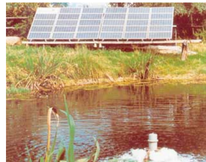
Bild 2: Monokristalline Module zur Teichbelüftung; monokristalline Module bieten hohe Langzeitkonstanz im Wirkungsgrad
