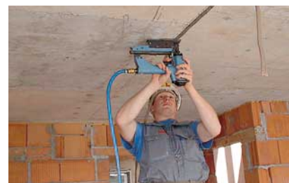
Bild 1: Ein Stegleitungs-nagler treibt die Nägel pneumatisch ein; das Gerät arbeitet auch auf harten Untergründen, z. B. Beton
