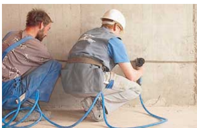
Bild 1: Ein Stegleitungs-nagler treibt die Nägel pneumatisch ein; das Gerät arbeitet auch auf harten Untergründen, z. B. Beton
