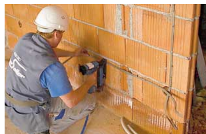
Bild 1: Ein Stegleitungs-nagler treibt die Nägel pneumatisch ein; das Gerät arbeitet auch auf harten Untergründen, z. B. Beton
