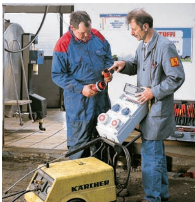
Bild 9: Dieser Landwirt – ein begeisterter Do-it-yourself-Bastler – wandte sich nach mehrfachen Anlagenstörungen letztlich doch an einen Fachmann. Dieser installierte eine Kombination mit Steckdosen der Schutzart IP67, weil dort mit Hochdruckreinigern gearbeitet wird
