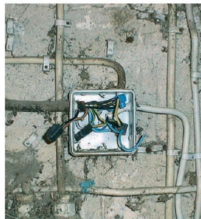
Bild 6: Unfachmännisch und unverantwortlich: Unter der blauen Klemme wurden die Meldeleitungen der Alarmanrichtung kurzgeschlossen. Beim E-Check wäre dies dem Fachmann sicher aufgefallen
