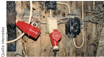
Bild 13: Solche Staubablagerungen auf elektrischen Geräten sollten regelmäßig entfernt werden, um unzulässig hohe Erwärmung zu vermeiden und so einem möglichen Brand vorzubeugen
