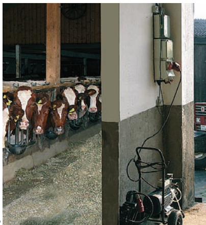
Bild 7: Diese Steckdosenkombination mit integrierter Absicherung ist bereits seit 25 Jahren im Einsatz, allerdings wurde die Kombination regelmäßig von Ablagerungen und Schmutz gereinigt und die Kontakte mit Pflegeöl behandelt
