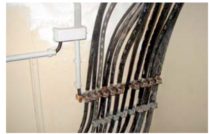
Bild 2: Gute Schirmmethode von Kabeln
