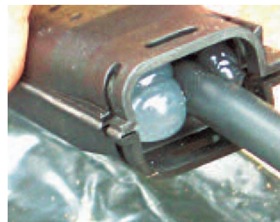
Bild 2: Nach dem Verschließen quillt isolierendes Gel aus der Muffe
