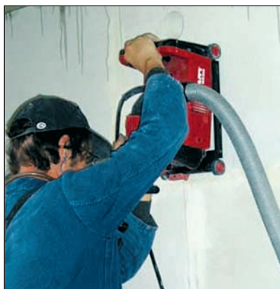
Bild 1: Bei Arbeiten mit Mauernutfräsen entstehen für Beschäftigte gesundheitsgefährdende Stäube
