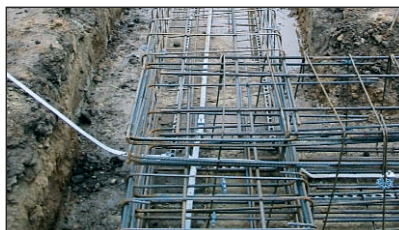
Bild 1: Fundamenterder innerhalb der Bewehrung mit Anschlussfahnen nach außen und innen
