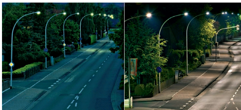
Bild 2: Straßenbeleuchtung vor (li.) und nach (re.) der Modernisierung: Die Anschlussleistung sank um über 50%
