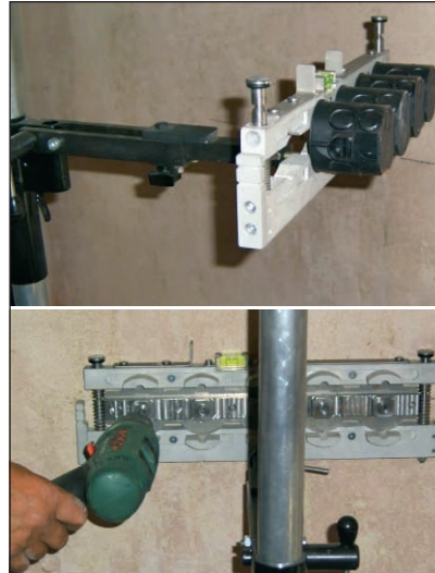
Bild 1: Der Dosenfix wird mittels integrierter Wasserwaage justiert und an eine Stange fixiert, dann erfolgt die Bohrung der Zentrierlöcher
