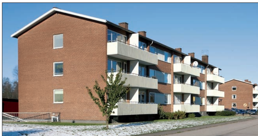
Bild 2: 72 Apartments mit insgesamt 4400 m 2 Wohnfläche in vier Häusern werden im schwedischen Oskarsström mit Wärmepumpen beheizt. Der Besitzer, die Immobiliengesellschaft Limhamnshus, stellt Zug um Zug alle seine Apartmenthäuser auf diese energiesparende Heizung um
