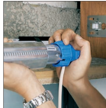
Bild 7: Die Welle bis zum Anschlag auf den Adapter schieben
