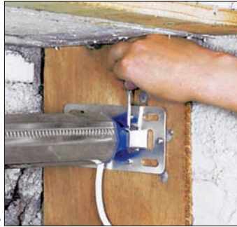
Bild 9: Welle in das Antriebslager einhängen und mit Splinten sichern
