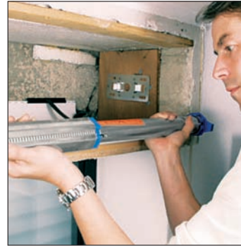
Bild 6: Motor in die Wickelwelle schieben
