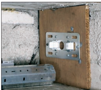
Bild 3: Das Antriebslager motorseitig ausrichten und montieren
