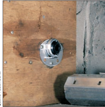
Bild 4: Das Gegenlager ausrichten und montieren
