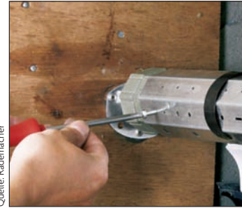
Bild 10: Längenausgleich durch Verschieben der Walzenkapsel, anschließend mit kurzer Schraube fixieren
