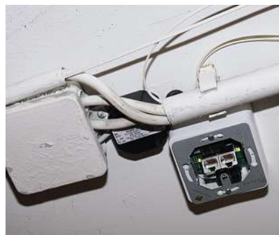
Bild 4: Kupfer-POF-Konverter für den Einsatz in einer Schalterdose (Rutenbeck)
