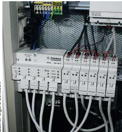
Bild 3: Kupfer-POF-Konverter (Rutenbeck) für die Hutschienenmontage
