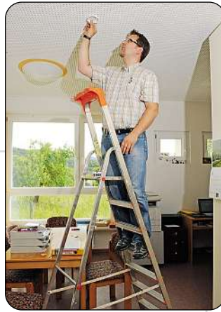
Bild 4: Für die Klebmontage bringt man das Klebepad auf der Rückseite an – bei Akustikdecken sicherlich die bessere Variante
