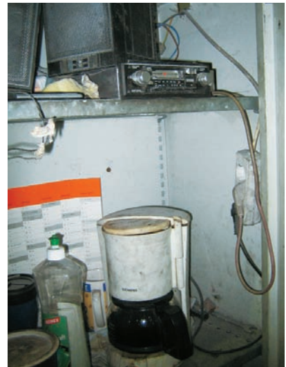
Bild 5: Haushaltsgeräte unzulässig durch Mitarbeiter im Metallschrank installiert und betrieben
