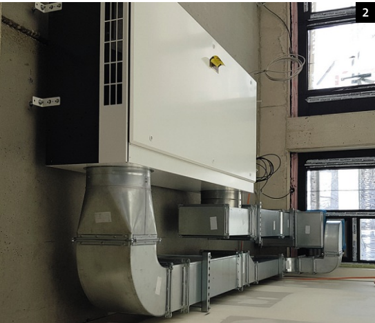
Bild 2: Die Airflow-Lüftungsgeräte der Duplex-Vent-Serie wurden an den Decken der jeweiligen Räumlichkeiten angebracht. Dabei musste darauf geachtet werden, dass die Montage nahe der Außenwand erfolgte
