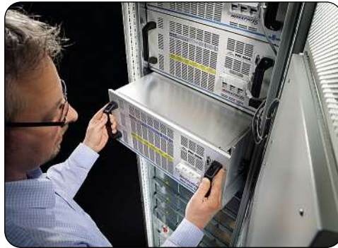
Bild 3: Ein Vorteil modularer USV-Systeme wie der PMC 200 von Rittal zeigt sich bei der Wartung: Fällt ein Modul aus, lässt es sich leicht im laufenden Betrieb durch eine Ersatzeinheit austauschen
